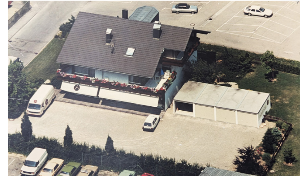
Unser Gebäude in den 80er Jahren
